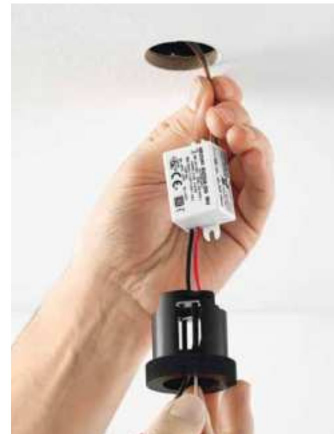
Montage RENDEL 28 mit Mini-LED-Treiber.
