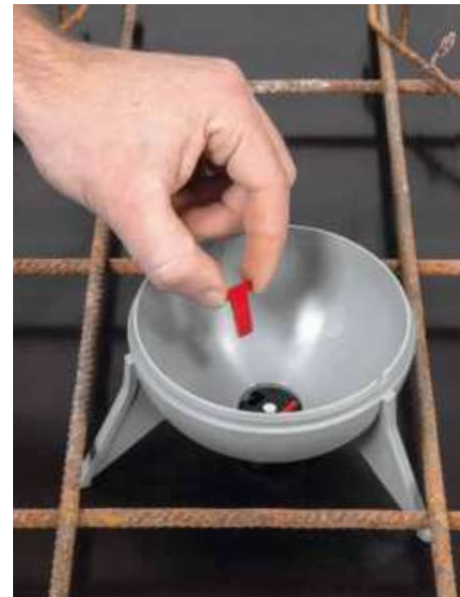
Die Sperrstifte verhindern das Aufschwimmen der Kapsel.
