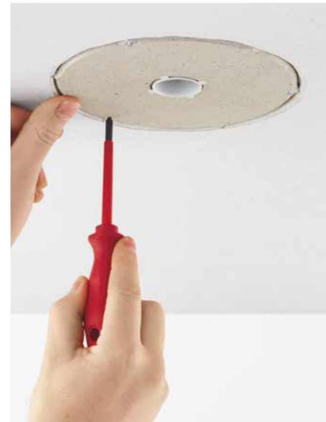
Die Fixierung erfolgt ohne Unterkonstruktion.
