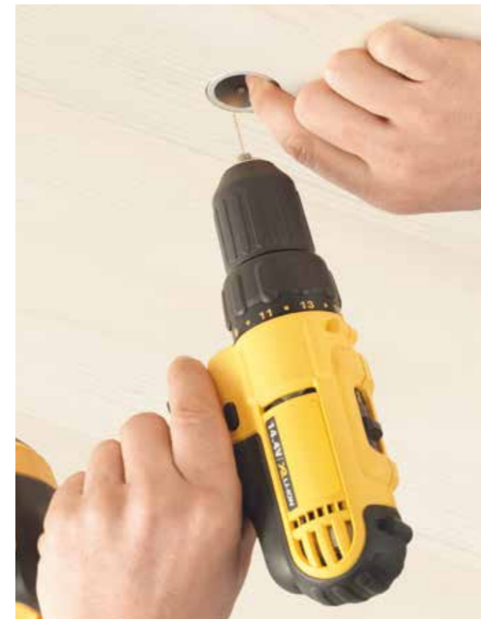
Montage Holzeinbauring
