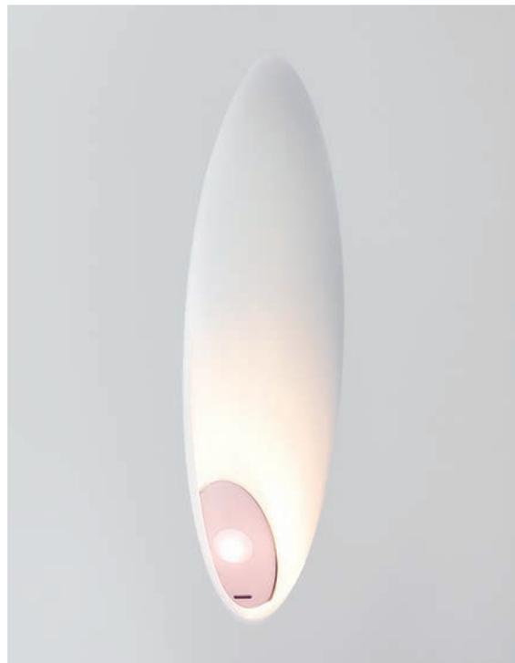
Die Lichtmodule werden an die Unterkonstruktion der Gipskartonwand angeschraubt und unter Beilage eines Gewebebandes flächenbündig verspachtelt.
