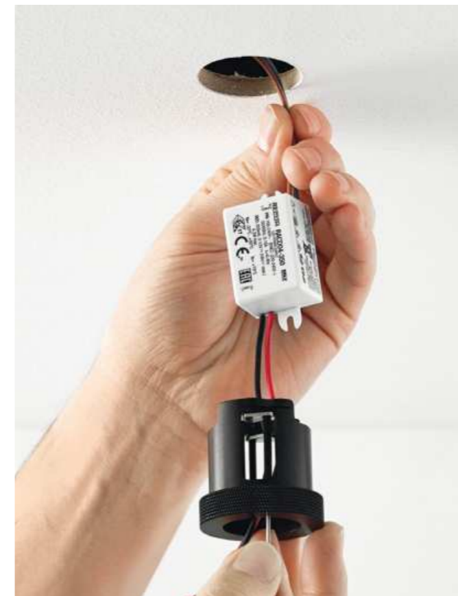
Montage RENDEL 28 mit Mini-LED-Treiber.
