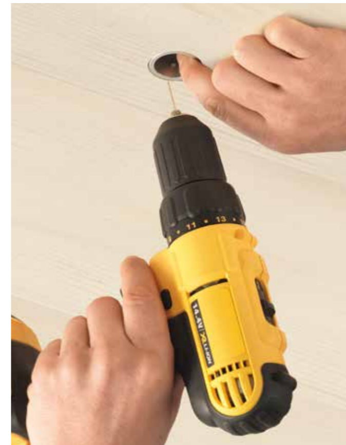
Montage HOLZEINBAURING 28.
