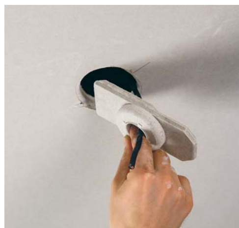
Einfache Montage des Spachteleinsatzes 68-28. Easy mounting of spatula infill 68-28.
