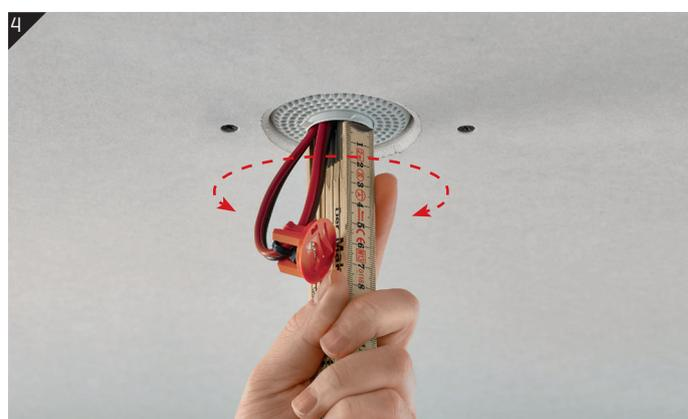
**Einbautiefe: 70mm INSTALLATION DEPTH: 70mm**
