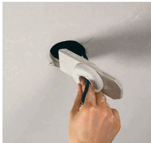
Einfache Montage des Spachteinsatzes 68-28. Easy mounting of spatula infill 68-28.
