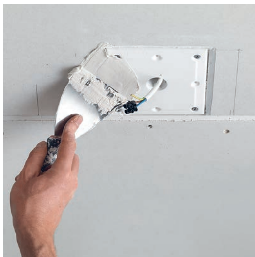
Unter Beilegung eines Gewebepandes werden die Module flächenbündig in die Decke eingespachtelt.
