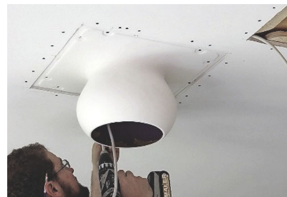
Montage eines Lichtmoduls: einpassen, anschrauben, spachteln, anstreichen, fertig
