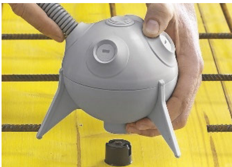
Beton: Einfach und beinahe werkzeuglos lässt sich die Betonkapsel auf der Schalung platzieren. Was sichtbar bleibt, ist ein abgefastes Loch mit Bajonett-Verriegelung
